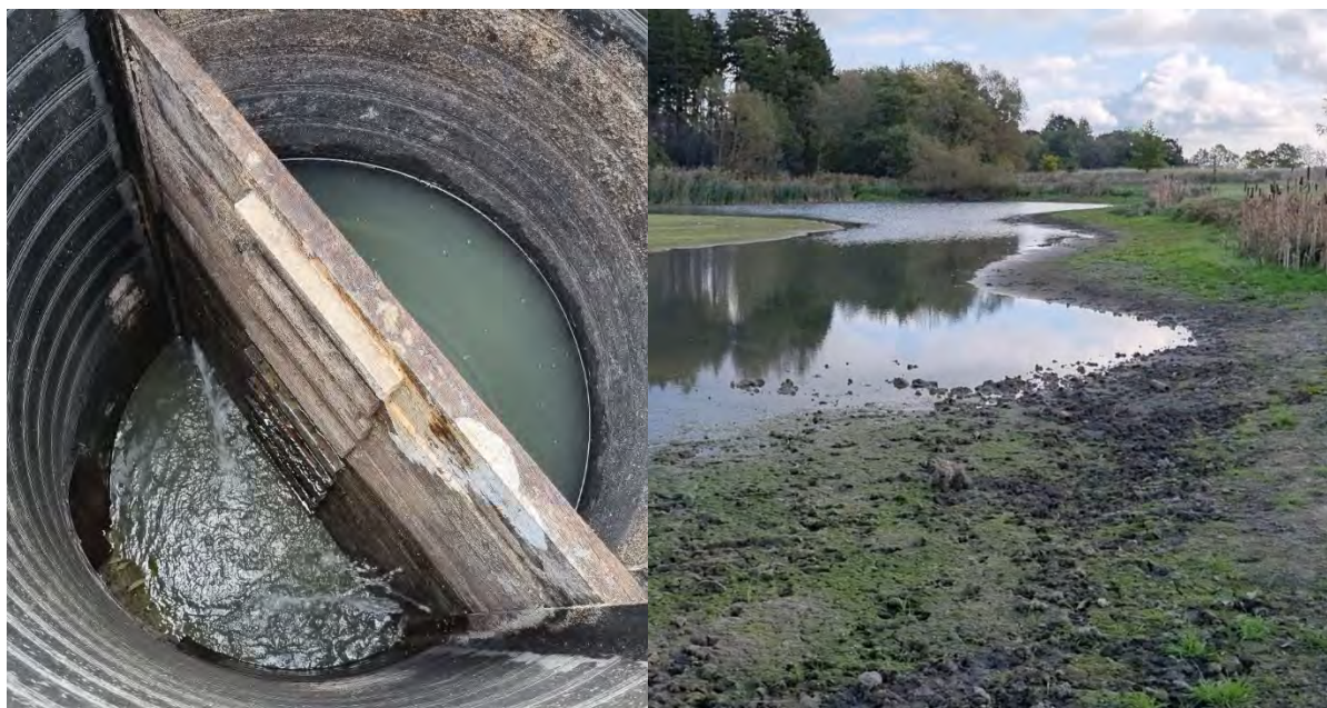
Bild 9. Till vänster: Bild tagen ner i en munkbrunn. Vattennivån till höger om brädorna är samma nivå som i våtmarken. Vattennivån är tänkt att stiga upp till den översta brädan, där det sedan ska brädda över. Eftersom det inte är tätt mellan de nedre brädorna läcker vattnet ut och når aldrig upp till den planerade nivån. Till höger: Våtmarken med för låg vattennivå till följd av den läckande munkbrunnen. Foto: Mattis Vindelmann
