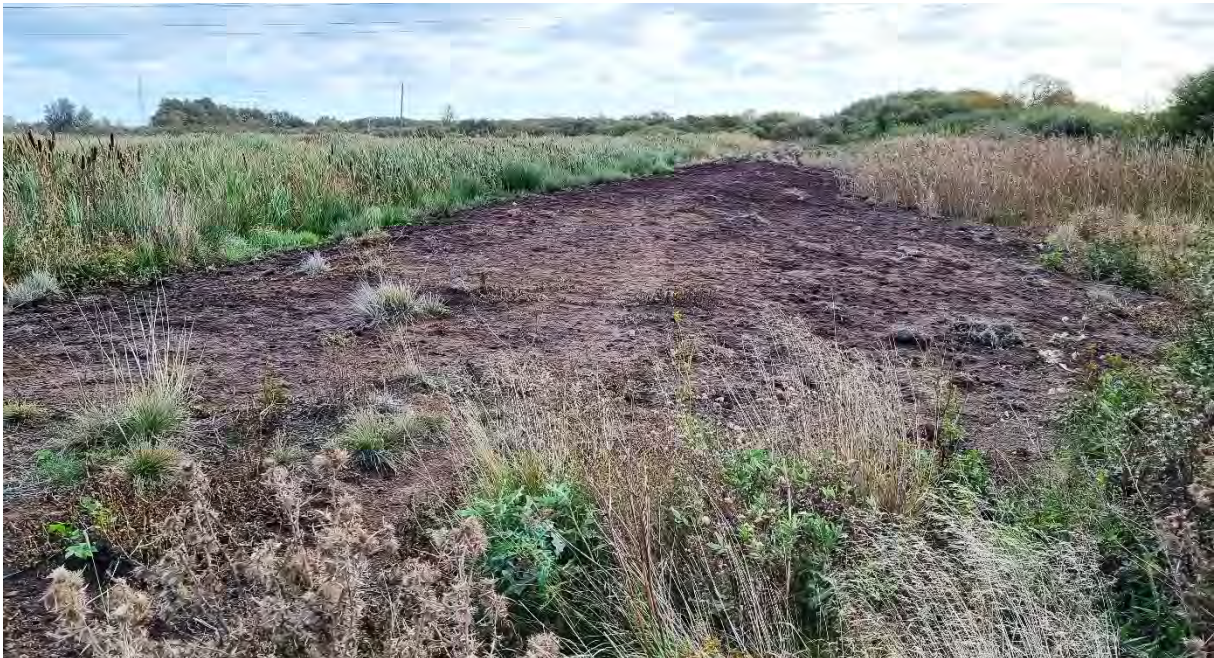
Bild 11. På många dammvallar med organogen jord är det svårt för vegetation att etableras, även flera år efter anläggning. Foto: Mattis Vindelmann.
