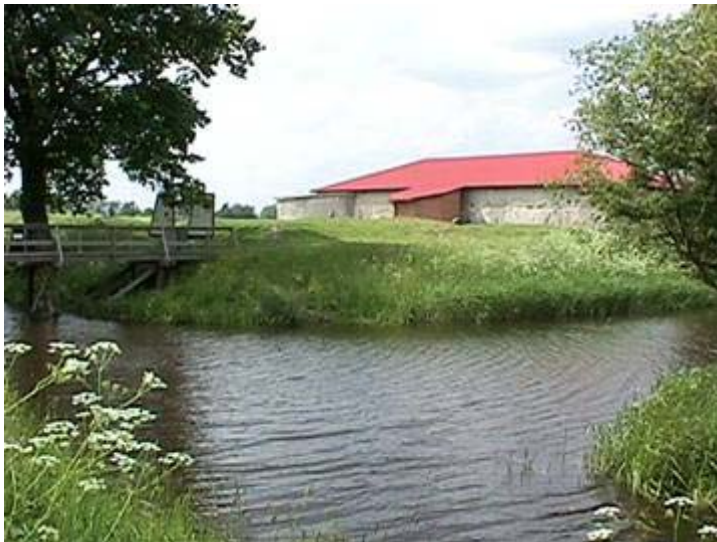
Lillö borgruin, är omgiven av en vallgrav. Av den en gång fem våningar höga byggnaden återstår endast ruinen av bottenvåningen, som nu skyddas av ett rött plåttak. Foto: S.-E. Magnusson 99-06-10
