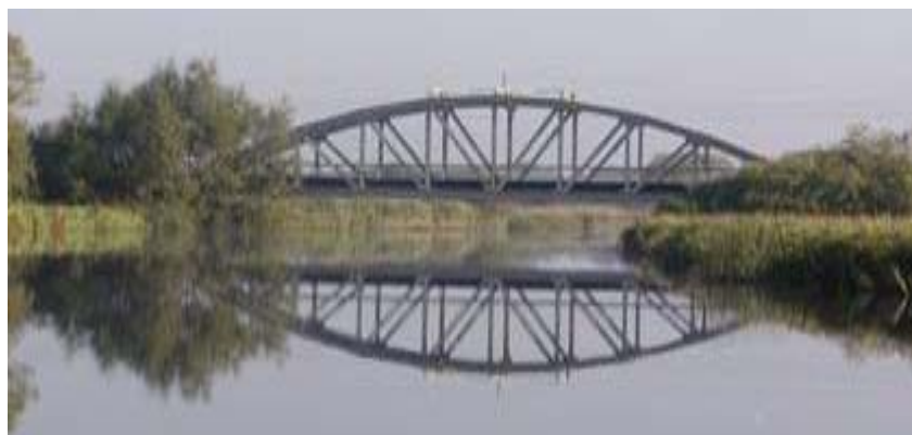
Den nitade, västra järnvägsbron över Helge å vid Lillö, byggd 1912. Foto: S-E. Magnusson 02-08-20
