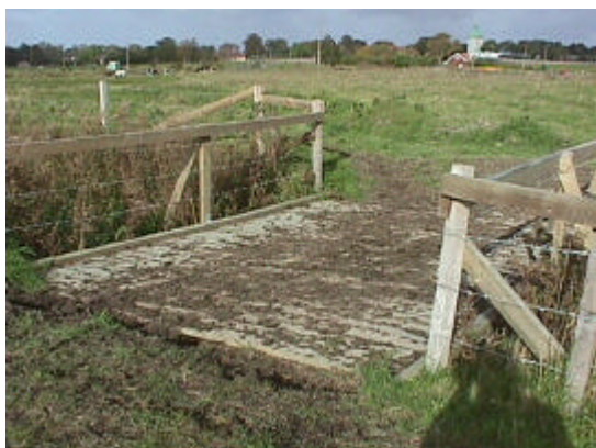
Nybyggd kobro över dike vid Herculesdammen, så att djuren kan nå alla de olika betesytor
