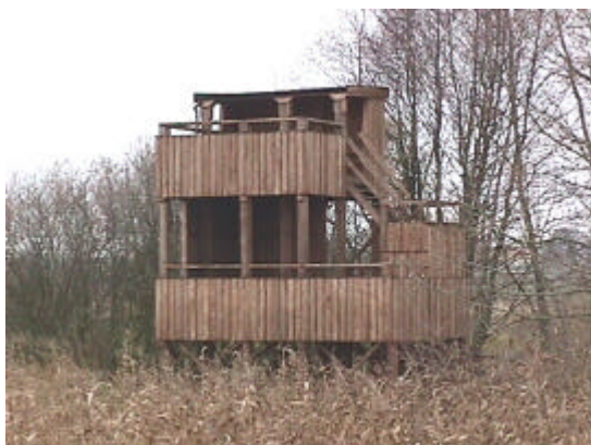
Byggarbetena på fågeltornet och det nya Utemuseet blev klart under året
