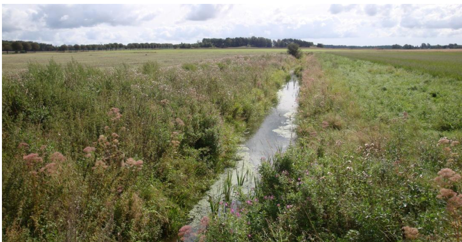
Figur 7. Diket där kulvertsystemen mynnar idag. Diket kommer att ingå i den planerade våtmarken.
