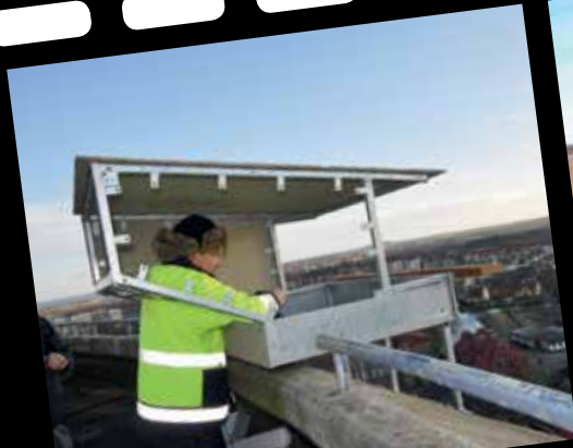
FOTO: KARIN MAGNTORN Ny holk monteras på Vattentornet.
