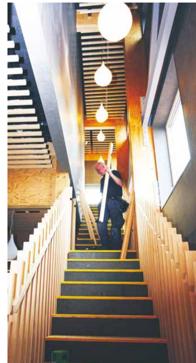
Trappan till andra våningen kläs med ribbor i ett formspråk som ska associera till den omgivande vassen.
